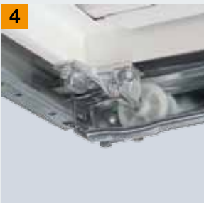
Паз для ходового ролика
